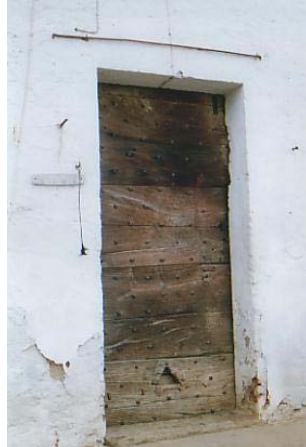
Portone ligneo laterale, d'ingresso alla cantina
