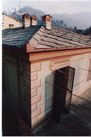
Particolare dei locali al primo piano
