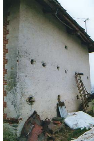
Facciata laterale dell'antico magazzino
