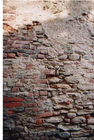
Particolare della muratura
