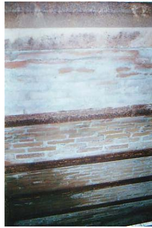
Particolare delle murature dell'antico ponte
