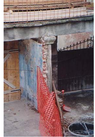
Vista della terrazza in pietra
