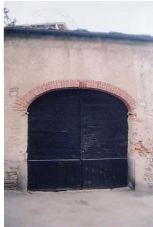
Portone d'ingresso, su Via San Prochietto
