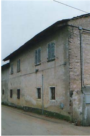
Facciata posteriore, con affaccio su Via Podere Devesio
