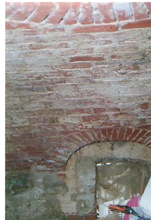
Particolare della volta laterizia dell'antica porcaiaia
