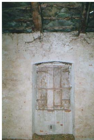
Apertura finestrata e particolare dell'antica copertura del tetto, in lose
