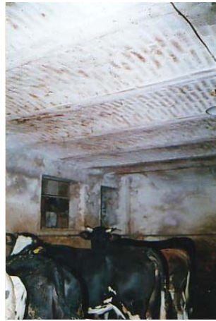
Vista d'insieme dell'interno della stalla, con voltini laterizi
