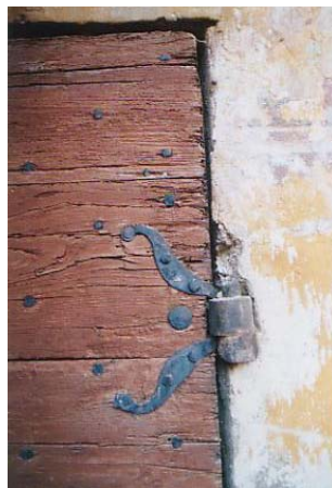
Particolare in ferro battuto delle antiche cerniere
