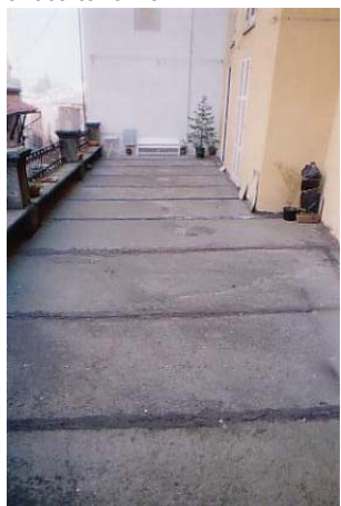
Particolare del piano di calpestio, in pietra, della antica terrazza
