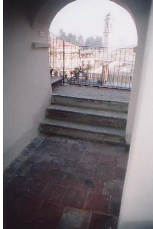
Apertura ad arco ed antica pavimentazione in cotto
