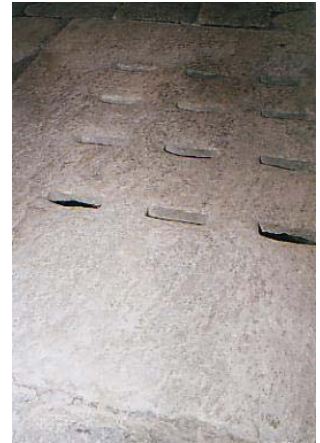
Particolare di uno scolo delle acque meteoriche, in pietra
