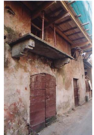
Vista complessiva della facciata, lungo Via Matteotti
