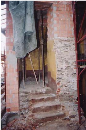
Particolare di un ingresso, con sezione delle murature
