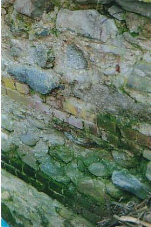
Strutture laterizie della campata dell'antico ponte
