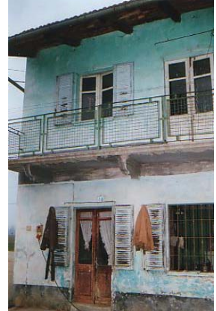
Particolare della facciata principale, con affaccio sulla corte interna
