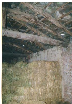
Orditura lignea del tetto e lose
