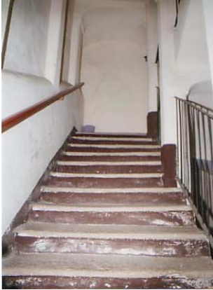
Particolare della scala, con battute in materiale lapideo
