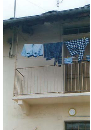
Il ballatoio del primo piano, con mensole in materiale lapideo
