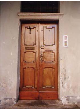
Porta di ingresso, con architrave lapideo
