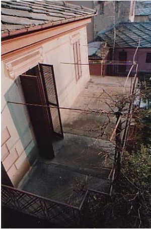
La terrazza in materiale lapideo, al primo piano
