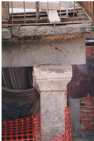
Particolare strutturale della terrazza
