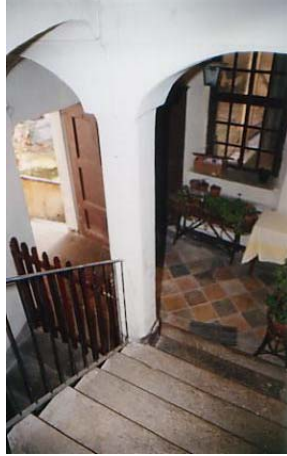
Vista della scala, con volte a botte ed antica pavimentazione in cotto
