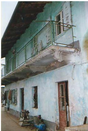
Facciata principale, con affaccio sulla corte interna
