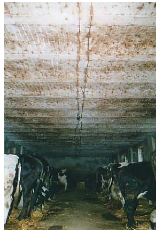
Vista d'insieme dell'interno della stalla, con voltini laterizi
