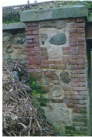
Strutture laterizie della campata dell'antico ponte
