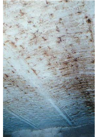
Particolare dei voltini laterizi
