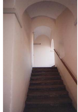
L'antica scalinata interna, con volta a botte
